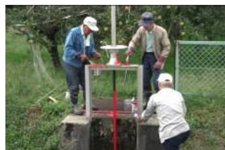
中川用水路水門塗装
